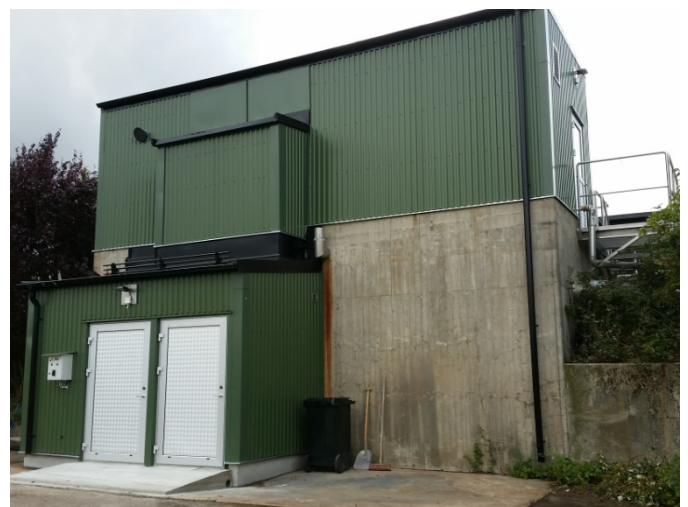
Ny överbyggnad och utbyggnad för sand- och rensbehållare.
