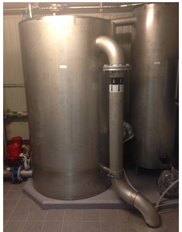
Nytt filter, hydrofor, fundament och golv i Östmarks vv.
